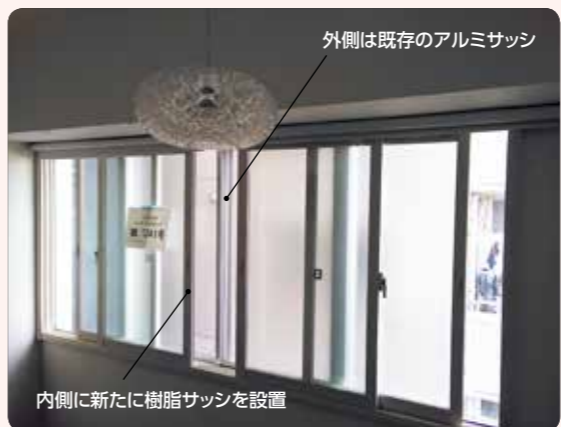
二重サッシに改修し、断熱性能を向上
