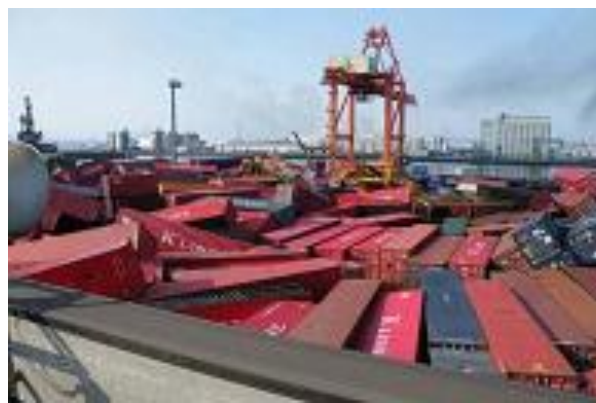
仙台塩釜港（高砂埠頭） 津波により流出したコンテナ
