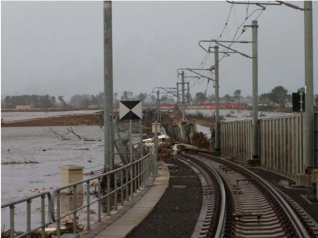
仙台空港アクセス鉄道 空港トンネル入口付近冠水，防音壁倒壊，瓦礫・土砂等流入状況
