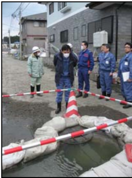
(溢水状況) 低地にて汚水がマンホールより溢水
