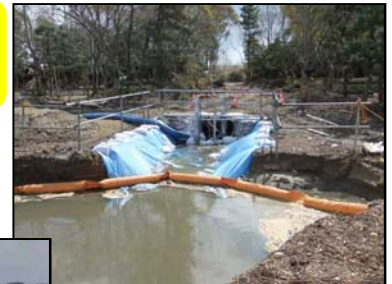
(応急処理状況) 処理場の外に 仮設沈殿池を設置。
