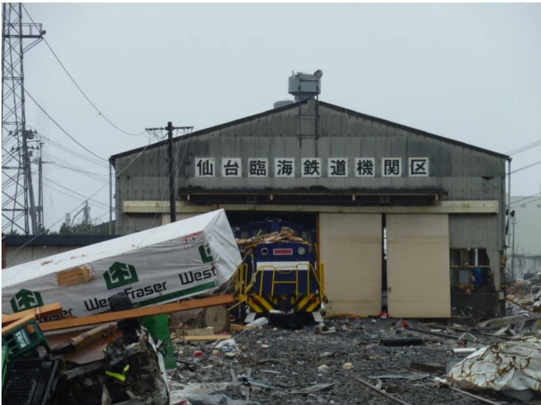
仙台臨海鉄道 仙台港駅構内機関区の状況
