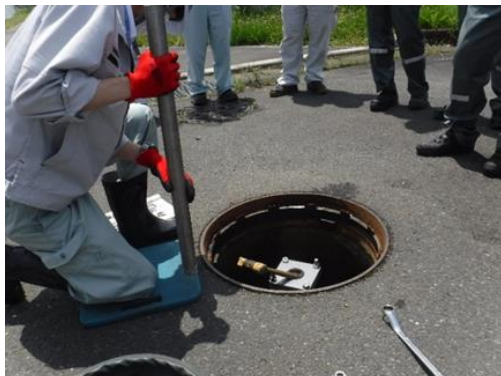
<実技（空気弁操作）>
