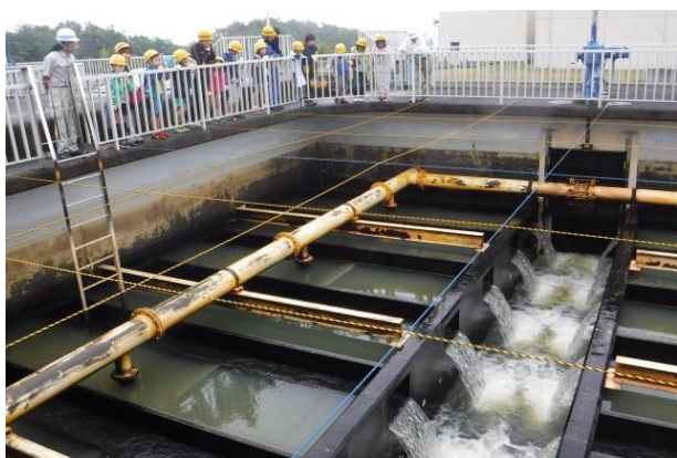
ろ過砂洗浄の様子
