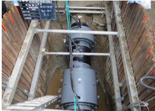
伸縮可撓管の補強状況
