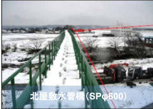
A1橋台側より撮影
