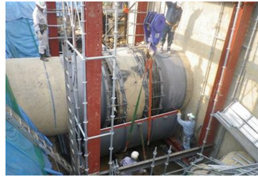
伸縮可撓管の補強状況
