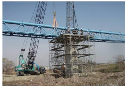
七北田川第2水管橋(復旧状況)
