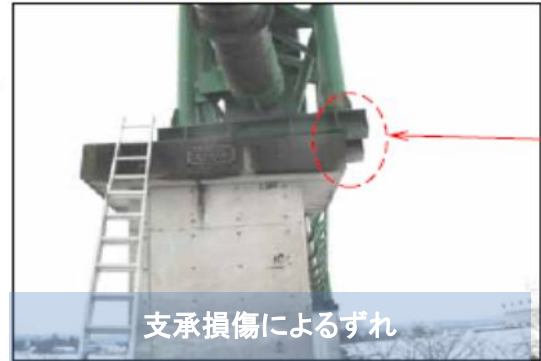
P1橋脚 (下側より撮影)
