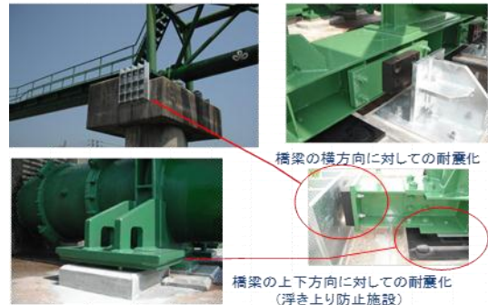
土手前水管橋の追加補強
