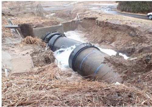
高区系送水管 伸縮可撓管の解脱
