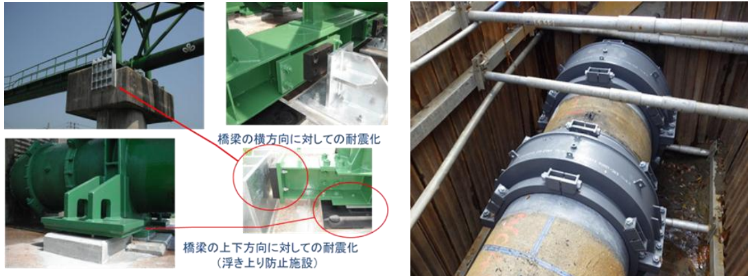
水管橋耐震補強例(大崎広水)
