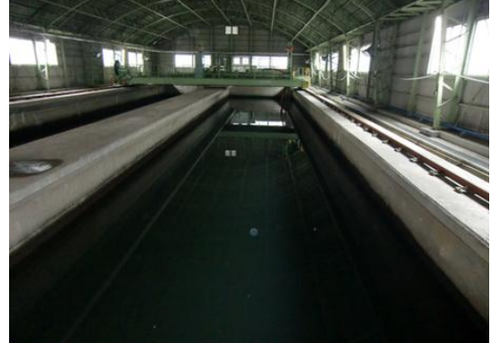
熊野堂沈砂池(耐震補強予定)
