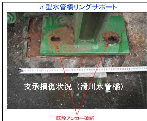
既設アンカー破断
