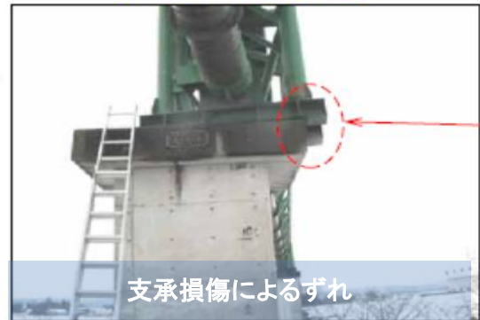
P1橋脚 (下側より撮影)
