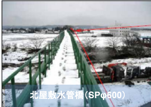
A1橋台側より撮影
