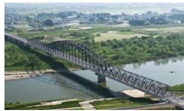
国道113号 丸森大橋 (丸森町)
