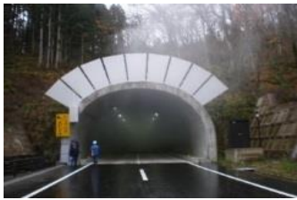
国道108号 荒雄湖トンネル (大崎市)
