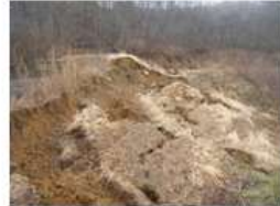
地震による堤体の崩壊
