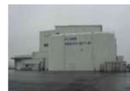
輸出対応型カントリーエレベーター
