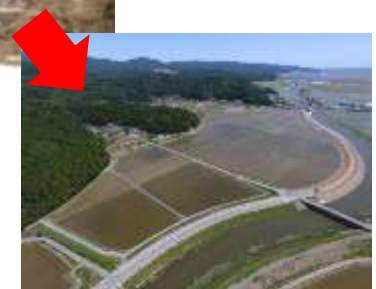
〔北上地区（石巻市）の復旧・復興〕
