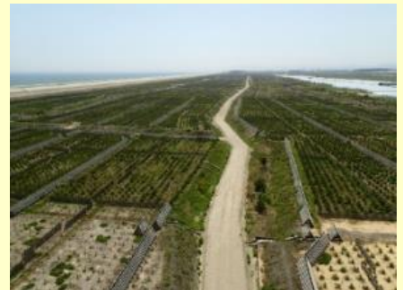
再生が進む海岸防災林 (名取市 平成29年5月)
