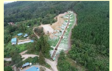
治山事業による復旧状況(山腹工)
