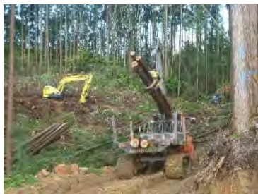
一貫作業現場の状況
