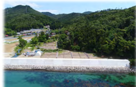
復旧した防潮堤
