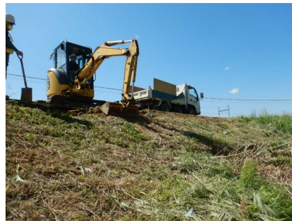
＜施工状況写真＞
