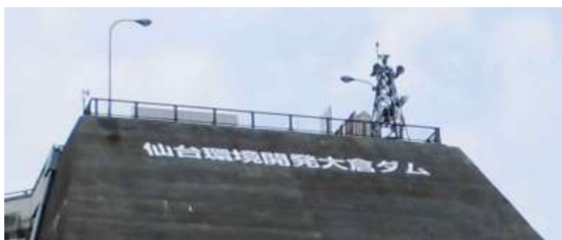
別添図3 ダム堤体への愛称表示
