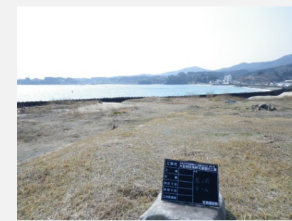
④ 着手前 平成26年3月
