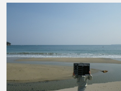
② 着手前 平成26年3月
