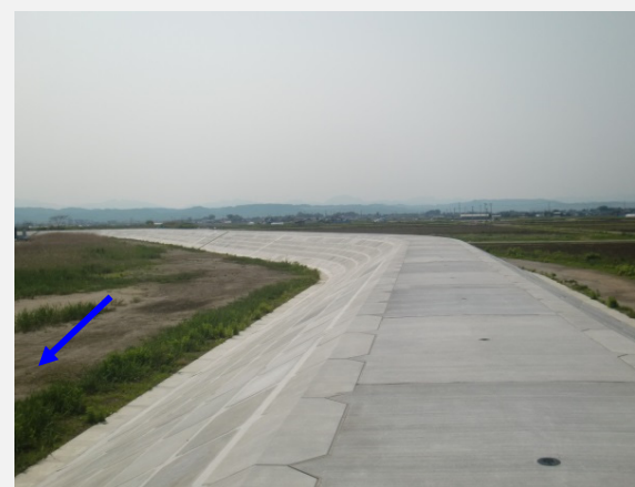
築堤・護岸工事が完了しました。
