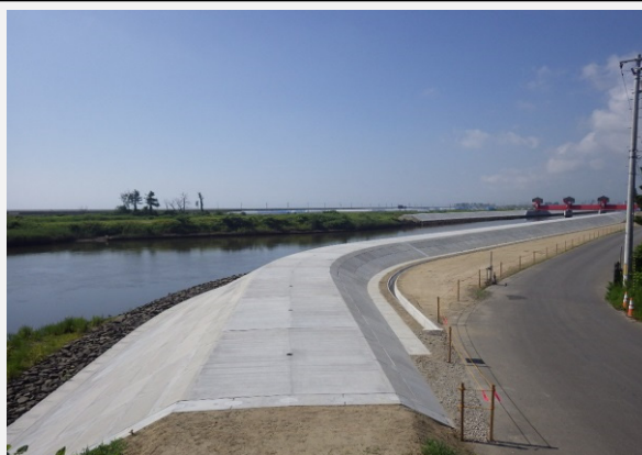
堤防が完成しました
