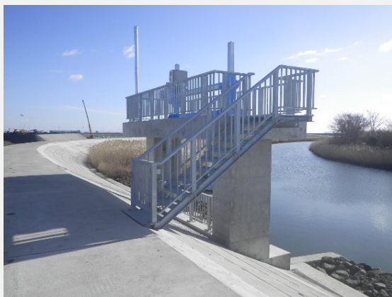
樋管のゲートの設置が完了しました。
