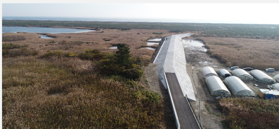
堤防が完成しました
