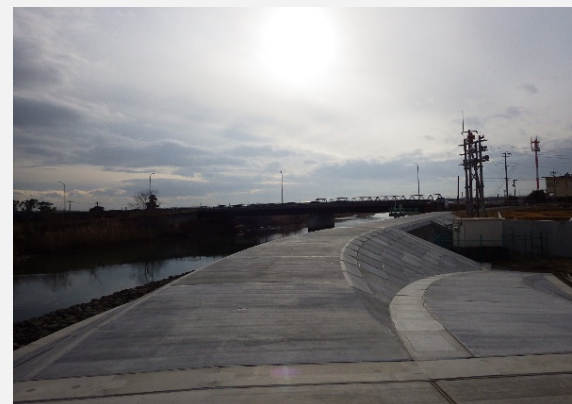
築堤・護岸工事が完了しました。
