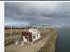
② 下増田工区着手前 平成24年12月
