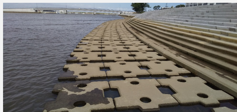
堤防が完成しました
