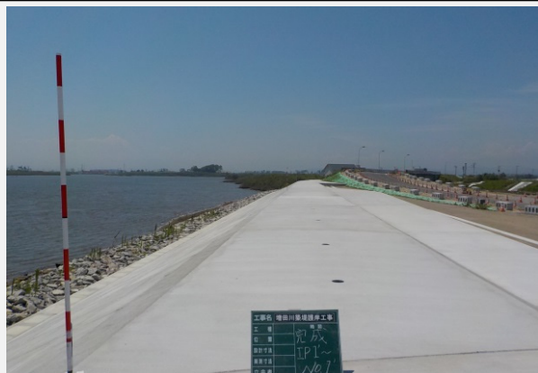
堤防が完成しました
