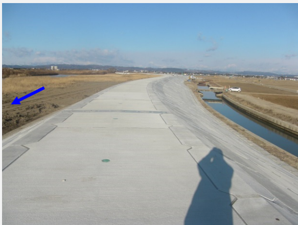
築堤・護岸工事が完了しました。
