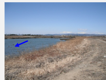
② 着手前 平成24年4月
