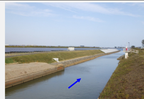
堤防が完成しました
