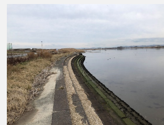
⑤ 東須賀工区着手前 令和2年2月
