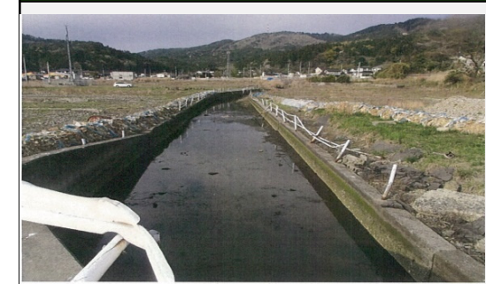
② 着手前 平成28年 5月
