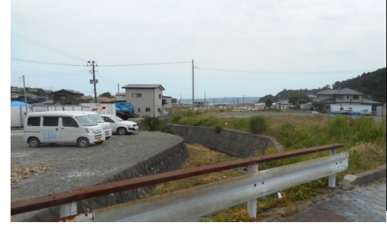
④ 着手前 工事終点 平成28年 5月
