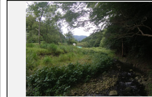
④ 着手前 平成27年8月
