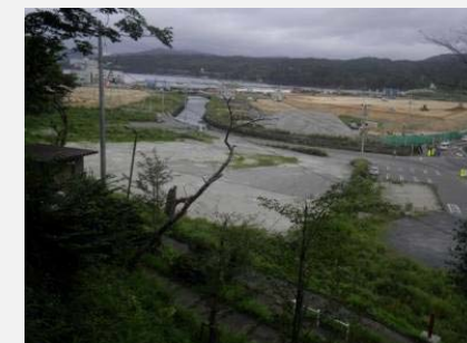
② 着手前 平成26年8月
