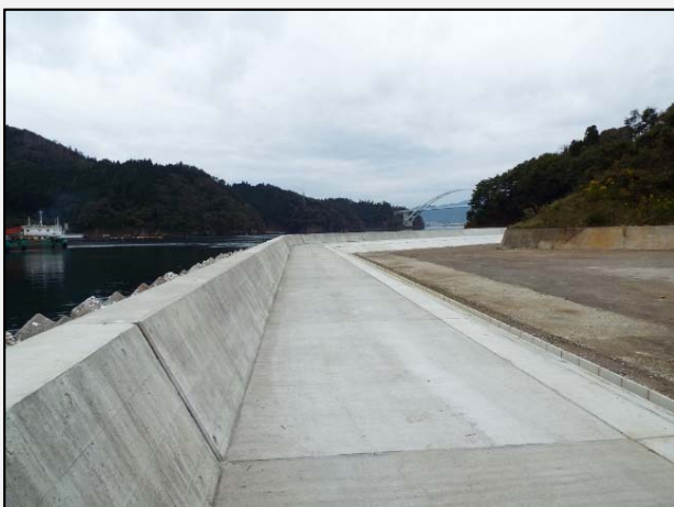
護岸工(中央部)
