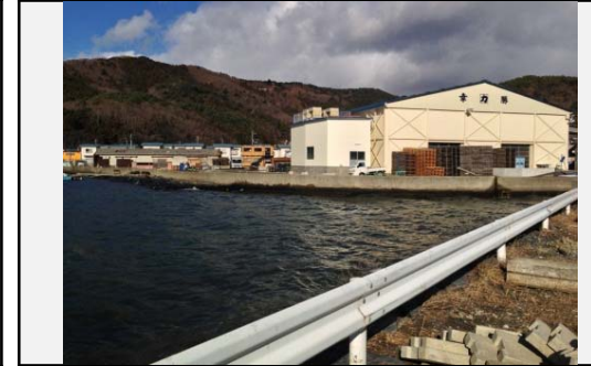
② 着手前 平成25年3月
