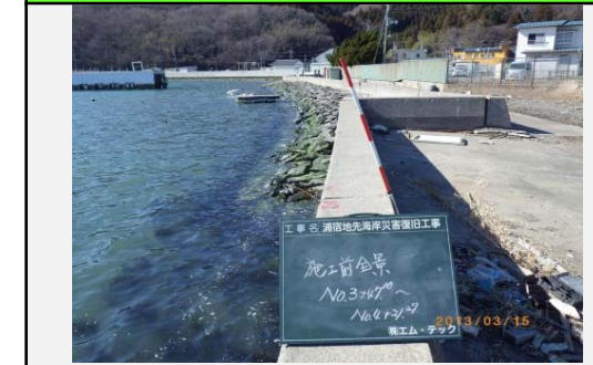
④ 着手前 平成25年3月
