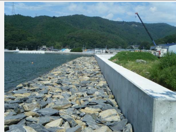
護岸工が完成了。
