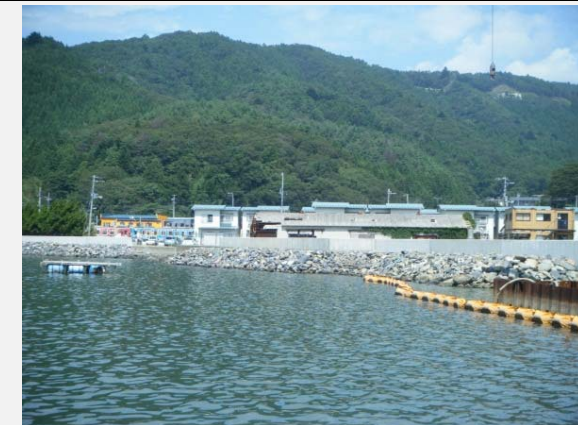
護岸工が完成了。
