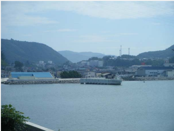
護岸工が完成了。
