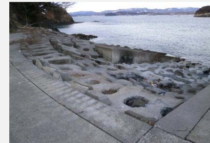
② 着手前 平成26年1月
