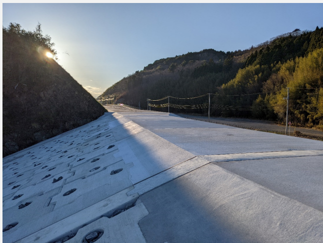
天端被覆工(海側より撮影)
