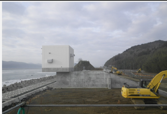
水門本体(起点側より撮影)
