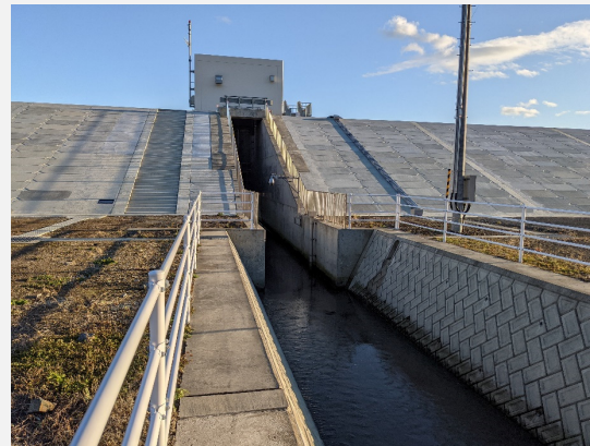
水門接続護岸工(陸側より撮影)
