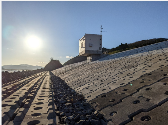
消波ブロック設置工(起点側より撮影)
