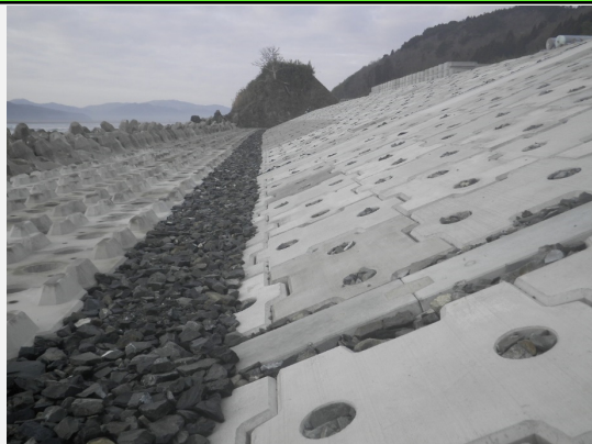
護岸基礎(終点側より撮影)
