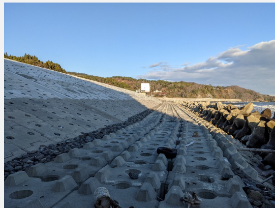
海岸表法ブロック設置工(終点海側より撮影)
