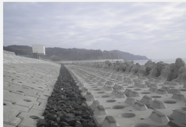
護岸基礎(起点側より撮影)
