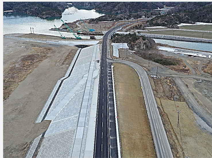
施工箇所空撮写真。
