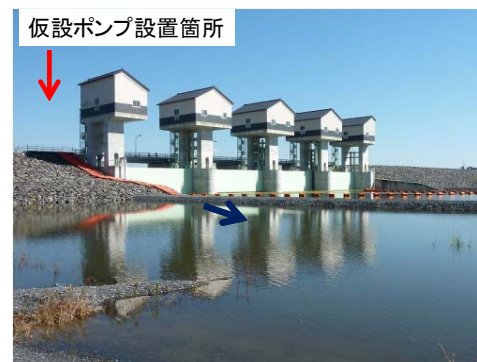
長沼水門（ダム左岸側）
