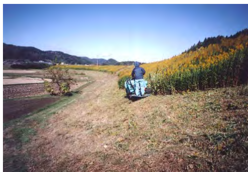
図 2-37 堤防の維持管理（内川）
