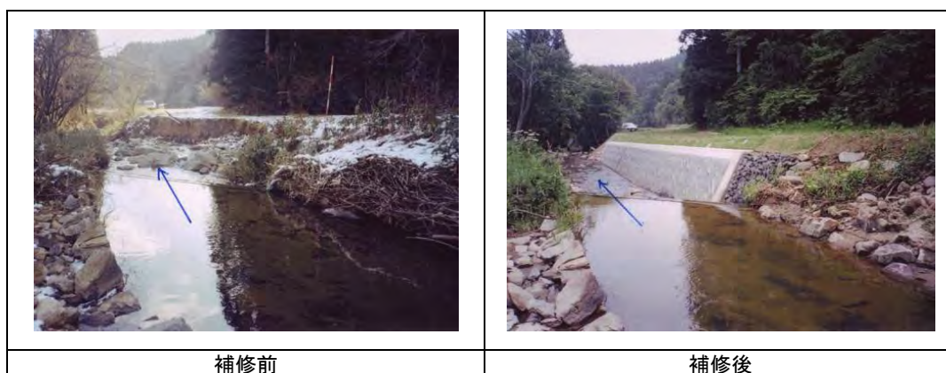
図 2-38 河道の維持管理（護岸の補修：小田川）
