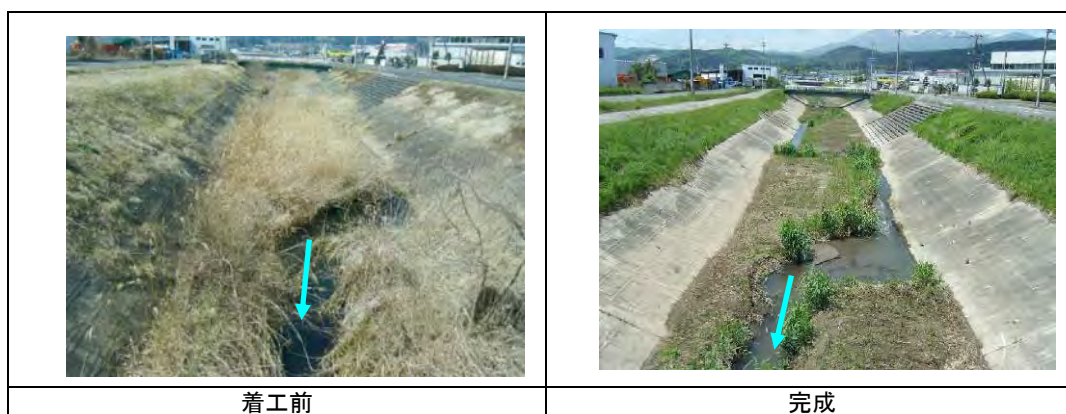
図 2-39 河道の維持管理（澗筋を残した堆積土砂撤去：白石市・大太郎川の事例）
