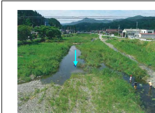
河床幅を広く取ったことで滞筋が自由に移動している例（気仙沼市・鹿折川の事例）
