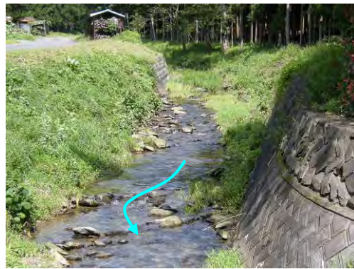
コンクリート護岸を用いているが、自然な水際が創出されている例（石巻市・馬鞍川上流の事例）
