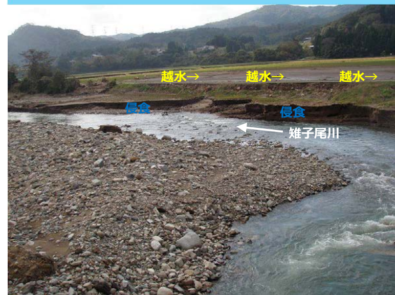
被害状況：雫子尾川
