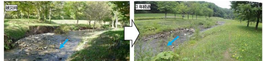
河畔樹林などを保全するため、元の河道、河床を改変させないで実施
