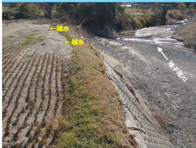
被害状況：雫子尾川
