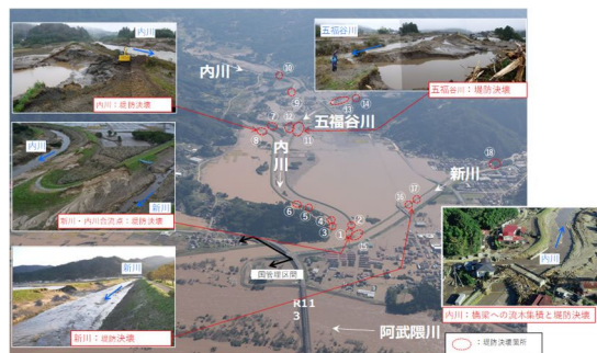
令和元年東日本台風 内川・五福谷川・新川浸水状況 (丸森町)
