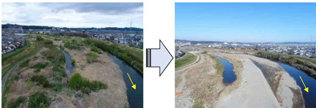
図 3.3 土砂撤去・支障木伐採例(七北田川)
