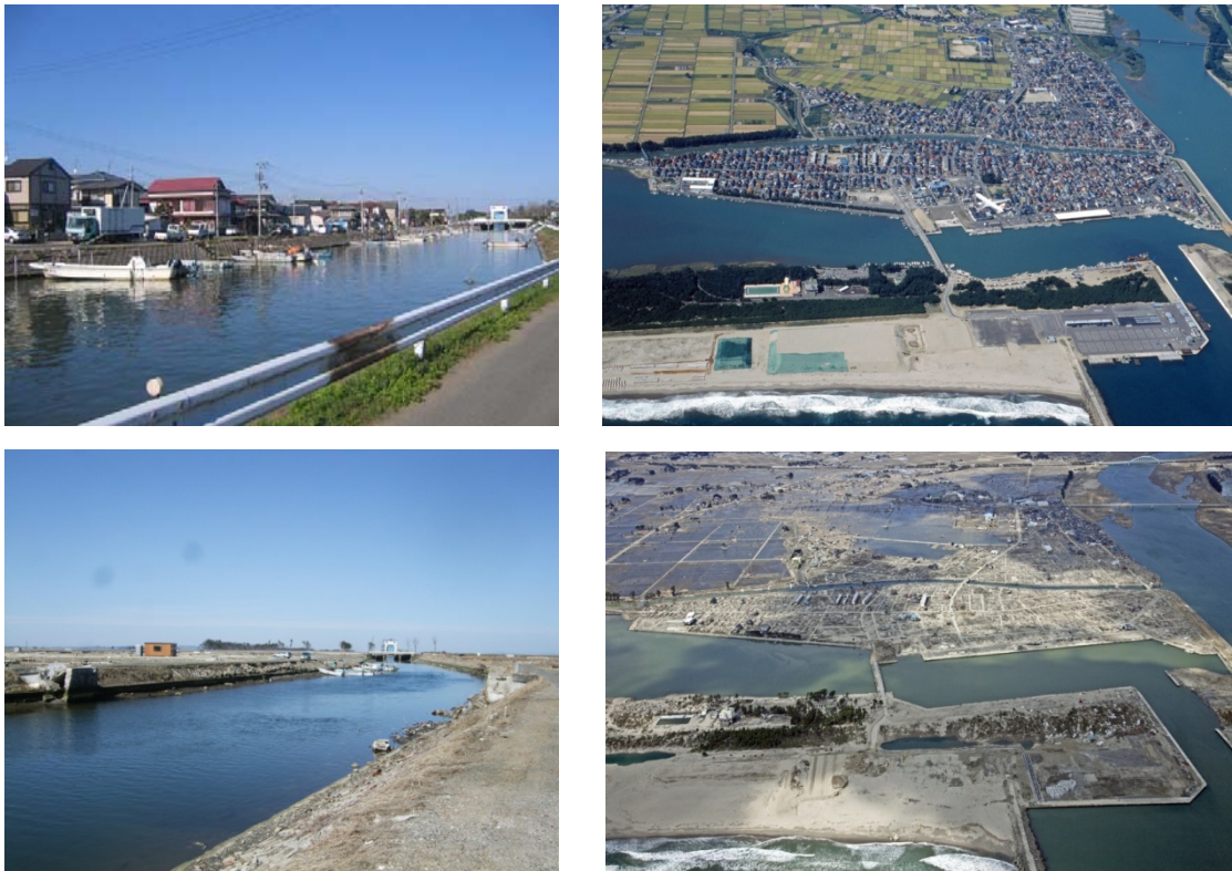
図4-5 名取市閑上地区の被災状況 (航空写真提供: (社) 東北建設協会)
