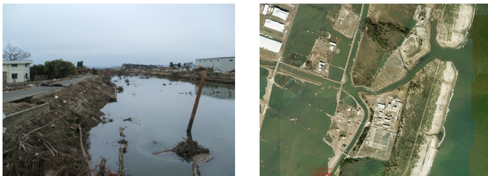
図4-6 木曳堀の被災状況
