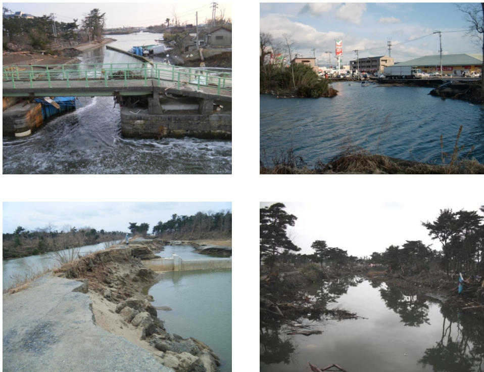
図4-11 北上運河（鳴瀬川水系北上運河，定川水系北北上運河，南北上運河）の被災状況
