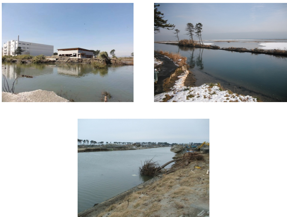
図 4-7 新堀の被災状況
