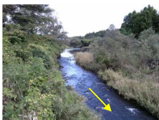
七北田川中流部 無名橋(約 23km 付近)より上流を望
