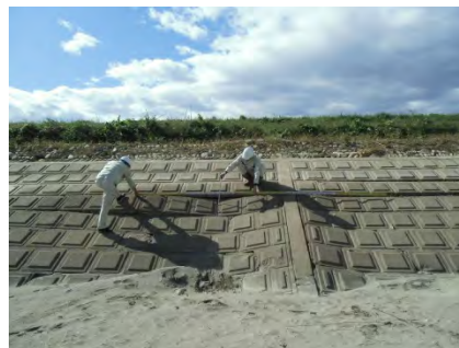
護岸の点検状況（七北田川）
