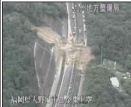
九州地方整備局 ※H21.9.3現在(消防庁発表) 福岡県大野城市乙金(九州縦貫自動車道)被災状況
