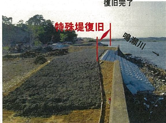
堤防復旧、護岸設置
