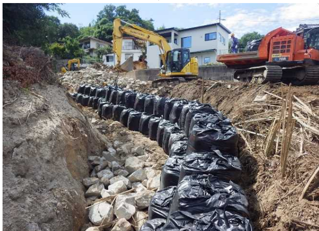
流路工整備により二次災害を防止 【広島市東区】
