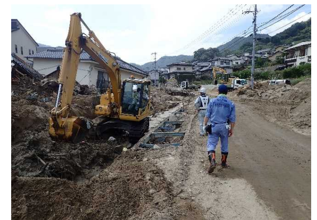
市街地の土砂等の撤去作業 【広島県坂町】
