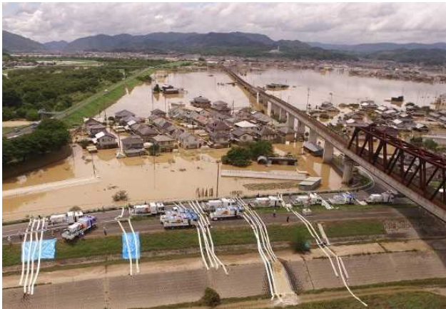
全国の排水ポンプ車23台を集結し24時間で排水 【岡山県倉敷市真備町】
