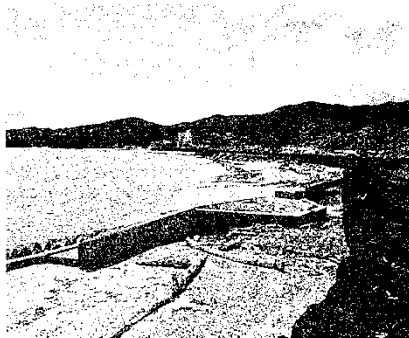
砂浜の上に防潮堤を築く計画が見直される大谷海岸—気仙沼市
