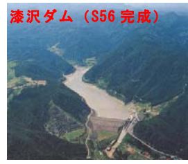
漆沢ダム（S56 完成） 宮城県（供用中）
