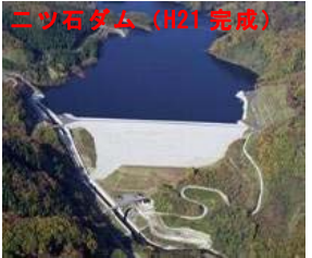
ニツ石ダム（N21 完成） 農林水産省（供用中）
