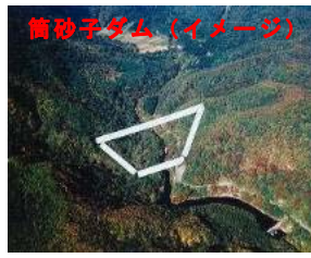
筒砂子ダム（イメージ） 宮城県（建設中）
