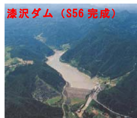
漆沢ダム (S56 完成) 宮城県 (供用中)
