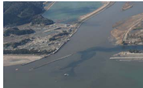
被災後河口部付近の状況
