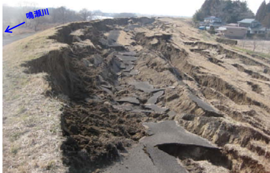
写真 2-25 鳴瀬川左岸 30.3k 付近
