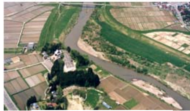
中流域の状況 (39km 付近)
