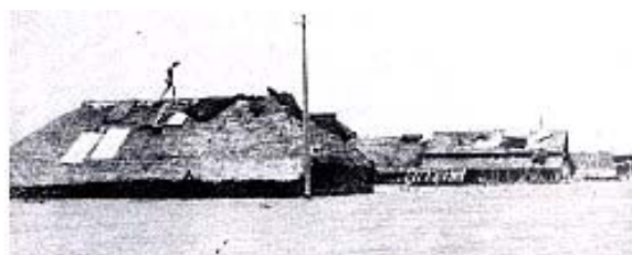
写真 2-6 洪水被害状況 吉田川 旧鹿島台町(大崎市)にて 堤防決壊と品井沼の溢水で浸水
