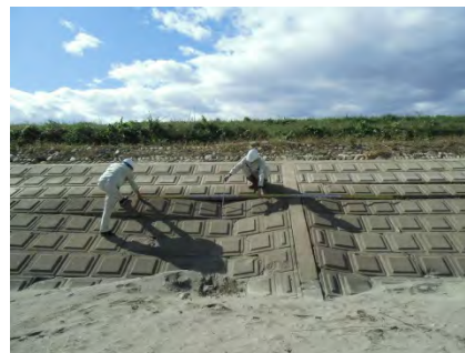
護岸の点検状況（七北田川）
