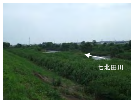
七北田川における河道内樹木の繁茂状況（岩切地区）
