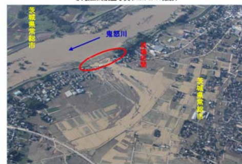
決壊区間航空写真(H27/9/11撮影)
