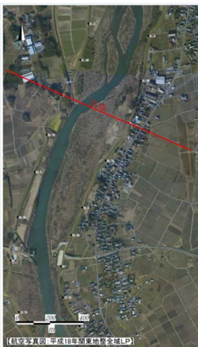
決壊区間航空写真図(H18撮影)
