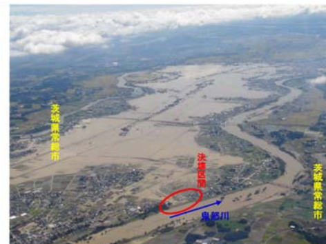
決壊区間航空写真(H27/9/11撮影)
