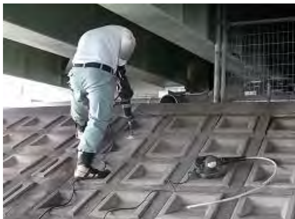
〈二次点検①〉 護岸削孔状況
