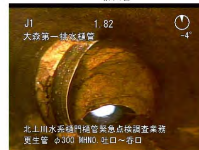
挿入式カメラ点検実施例
