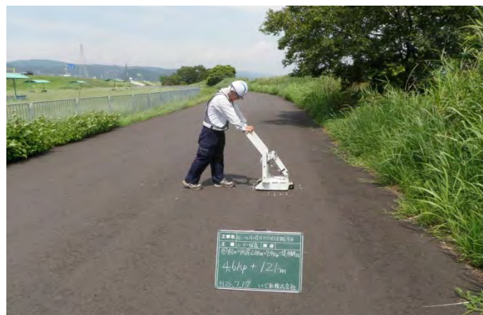
〈一次点検〉 手押し型レーダー
