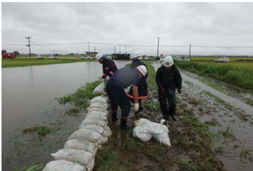
積み土のうによる越水防止 (北上川水系大江堀川)
