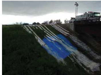
←排水状況 渋井川(岩木橋)
