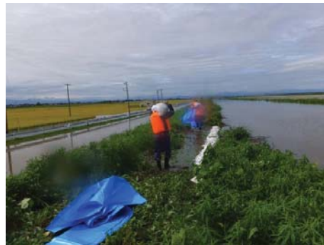
シート張り工法による洗掘防止 (北上川水系美女川)
