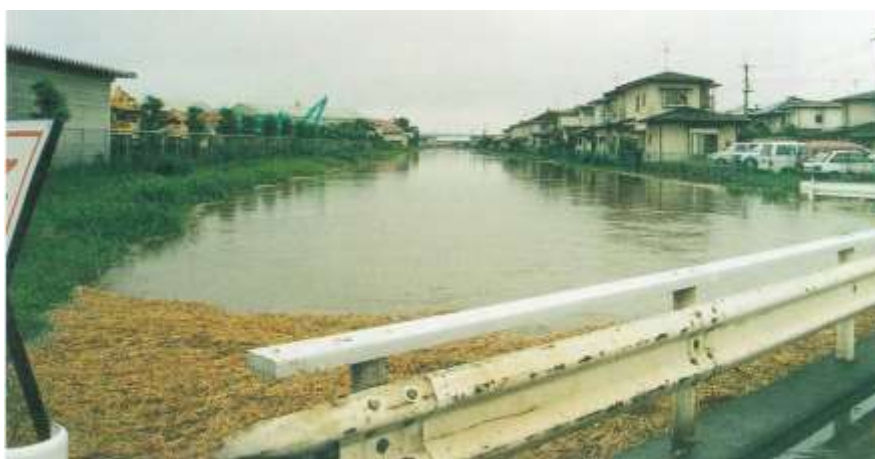
写真1-3 平成6年9月洪水時の川内沢川の状況（名取市植松4丁目）
