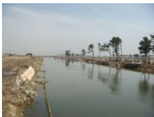
堤防の被災・流出 (南貞山運河)
