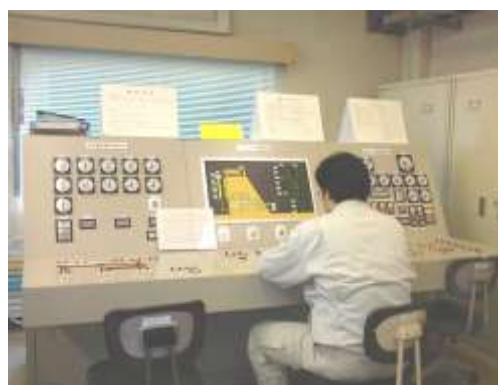
写真 2-10 樽水ダム保守点検
