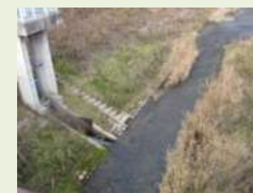
植生を確保した覆土護岸
