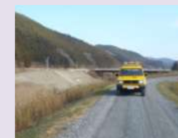
巡視など定期点検
