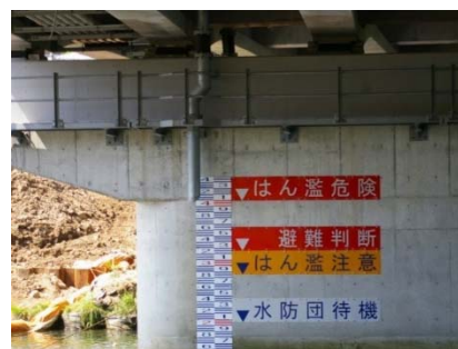
橋脚への水位表示例
