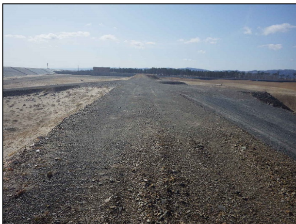
工所用道路撤去前状況
