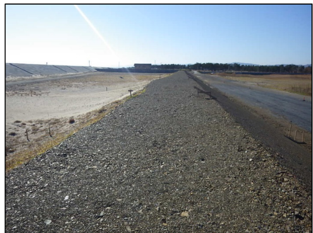
工所用道路撤去後状況
