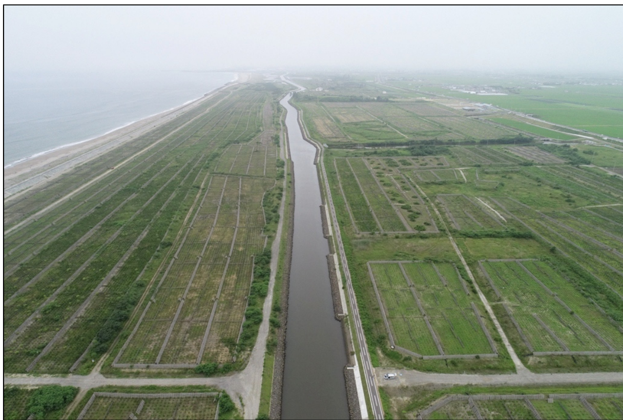
北貞山運河（大堀合流点側）の状況（令和2年7月21日）
