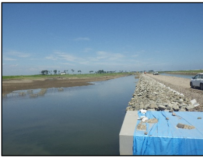
暗渠設置状況 (東谷地側)
