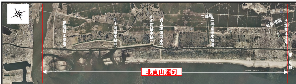
図 4-17-2 震災前後の北貞山運河の状況【北貞山運河】
