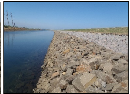
捨石+ストーンネット施工状況 (川表)
