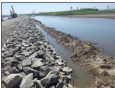
滯筋掘削状況
