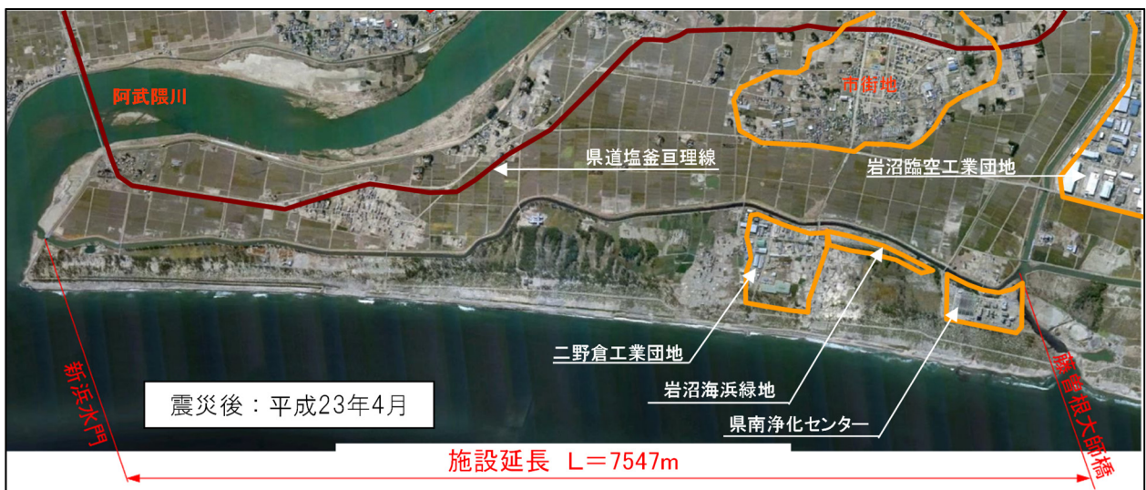
図 4-14-2 震災前後の五間堀川の状況（新浜水門～藤曽根大師橋区間）【五間堀川】
