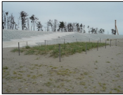
剥ぎ取った表土の置き土 (前浜側)
