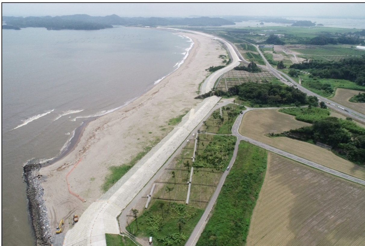
州崎海岸（北側）の状況（令和2年7月19日）
