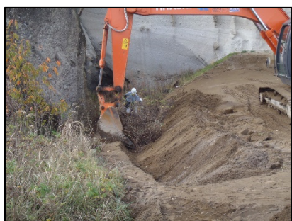
移植作業状況 （内陸側移植地）
