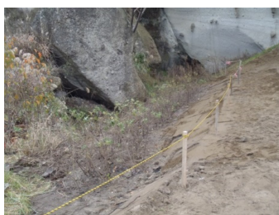
移植作業状況 （内陸側移植地）
