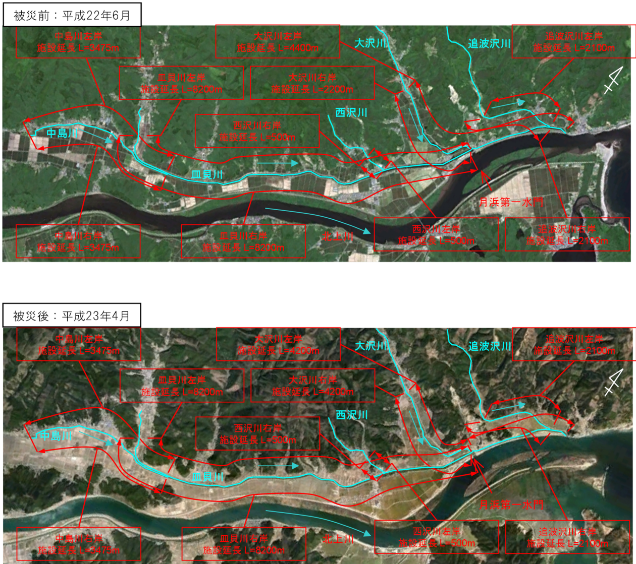
図 4-8-2 震災前後の大沢川外 4 河川の状況【大沢川外 4 河川】
